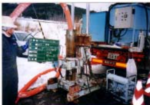
ケーシングパイプ建て込み
