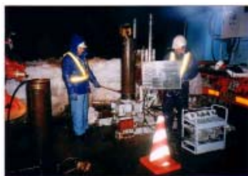
ケーシングパイプ引抜き
