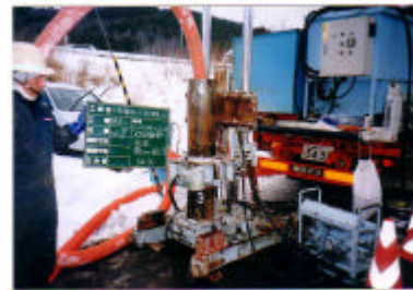
写真-1 コアチューブ圧入作業
