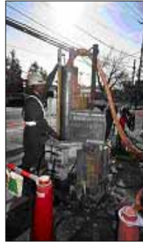
掘削・建て込み状況
